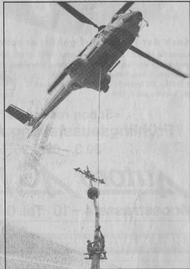
In luftiger Höhe sägen die Seilbahnspezialisten die Turmspitze, die bereits am Superpuma hängt, entzwei.
